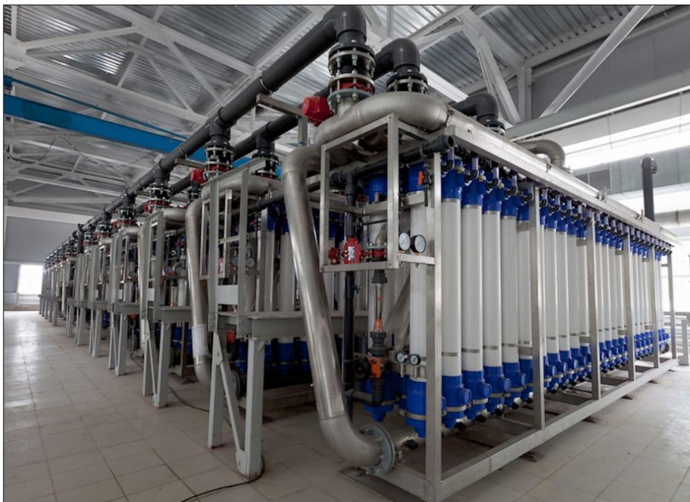
Рисунок 1.14. Блок ультрафильтрационных мембран
