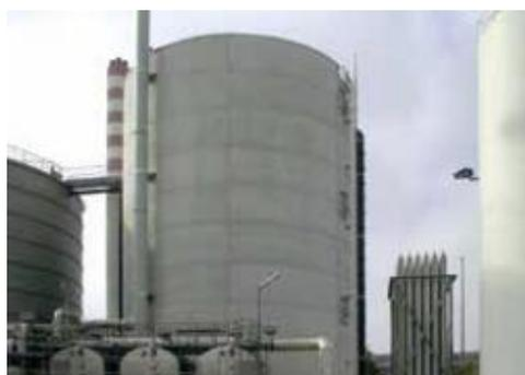
Рисунок 1.7 - Башенный биофильтр в Швейцарии (16 м)
